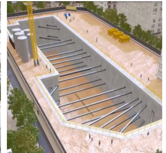
*Construction de l'espace souterrain : parois moulées (à droite) et méthode de creusement à ciel ouvert (à gauche)*
